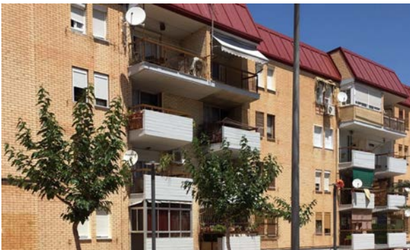
Imagen tras rehabilitación
