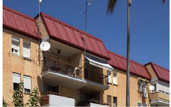
Imagen tras rehabilitación
